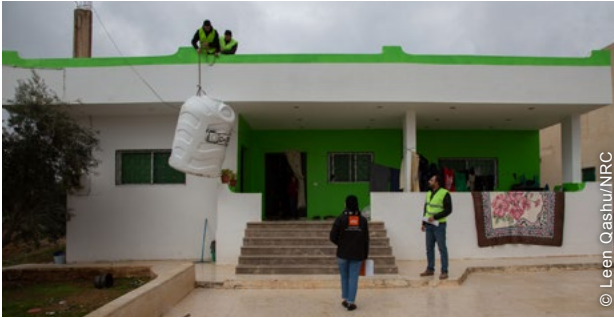
شملت إعادة تأهيل المياه والصرف الصحي والنظافة الصحية التي أجريت كجزء من البرنامج تركيب خزانات المياه.
