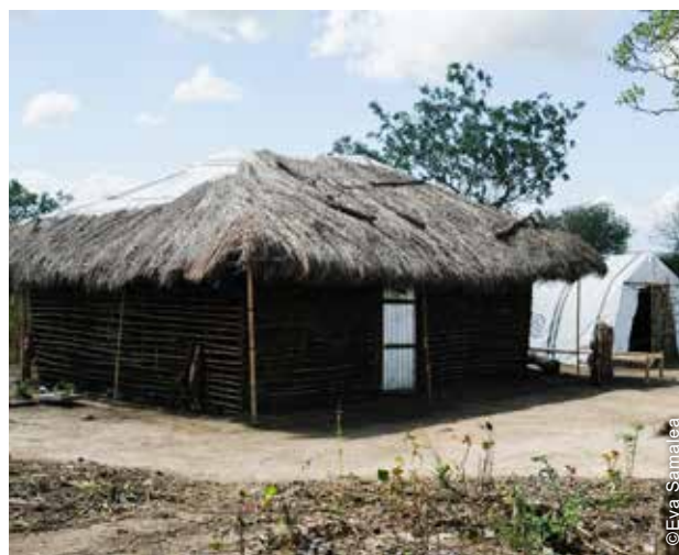
Abrigo de emergência e Abrigo semipermanente (de construção própria) enquanto parte da estratégia de modernização numa mesma família, Área de realociação de Ntokota, Metuge, Cabo Delgado.
