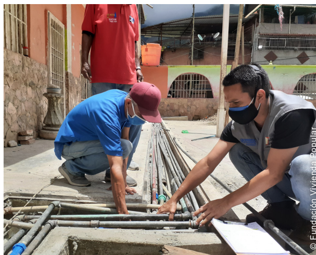
Las intervenciones a nivel comunitario incluyeron la rehabilitación de los conductos de agua.
